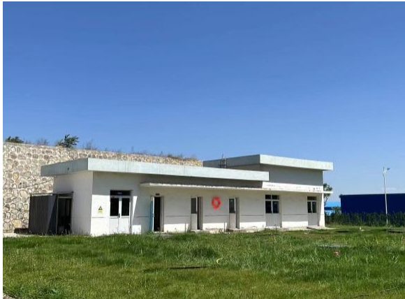
现有生活污水处理站
