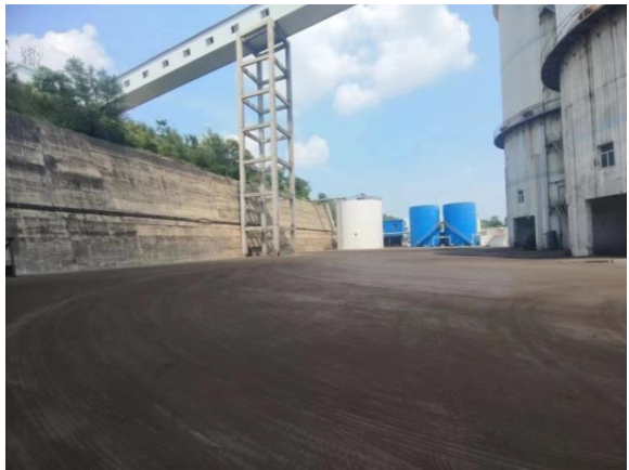
项目东侧（现有矿井水处理站）
