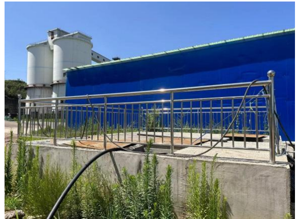
现有洗车平台沉淀池
