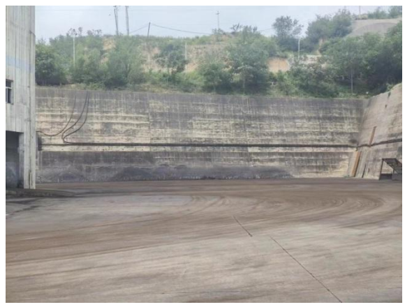
项目西侧（现有挡墙）
