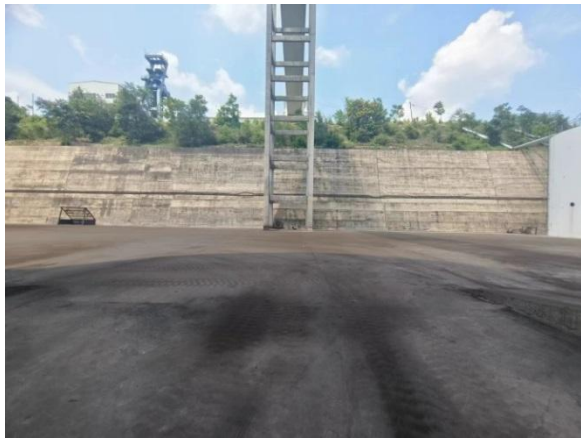
项目北侧（现有挡墙）
