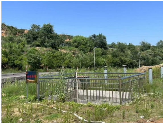
现有初期雨水收集池
