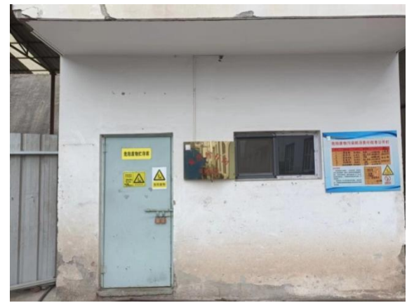
现有危废暂存间
