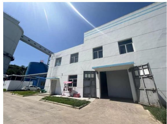
现有矿井水处理站
