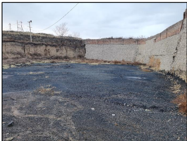
厂区东侧现状
