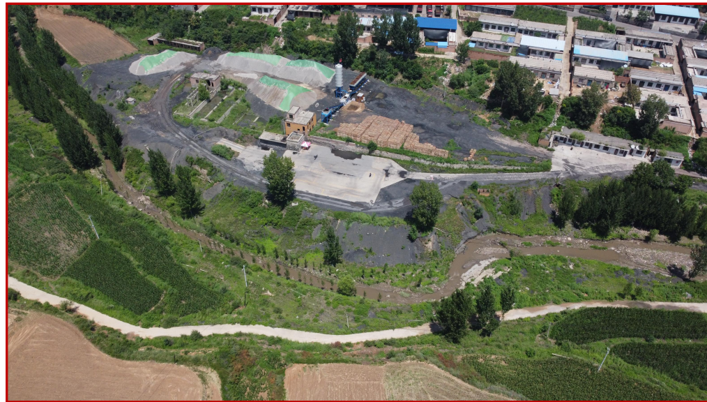
场地现状（航拍俯瞰图）
